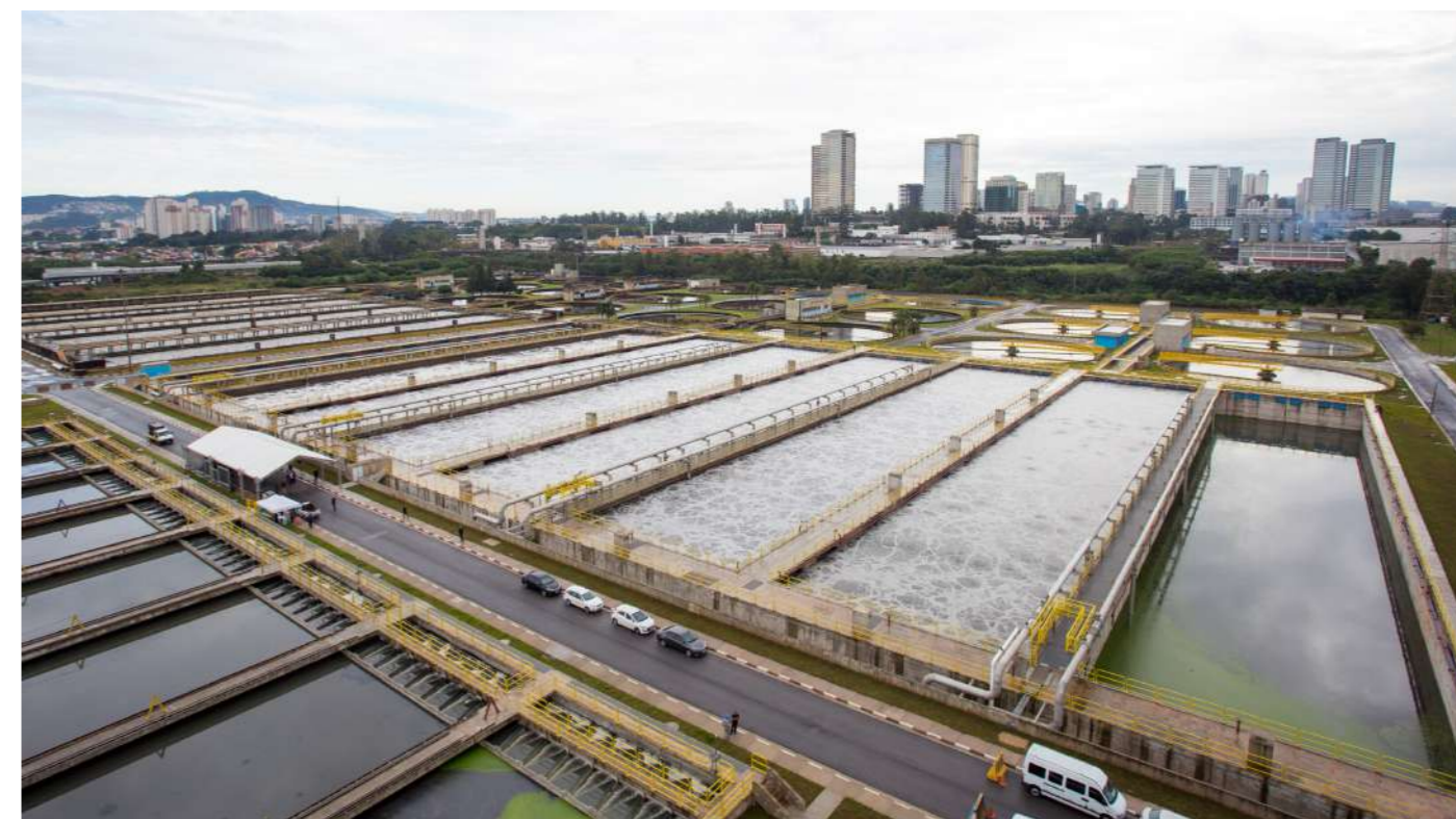
Estação Elevatória de Esgoto Piqueri.
